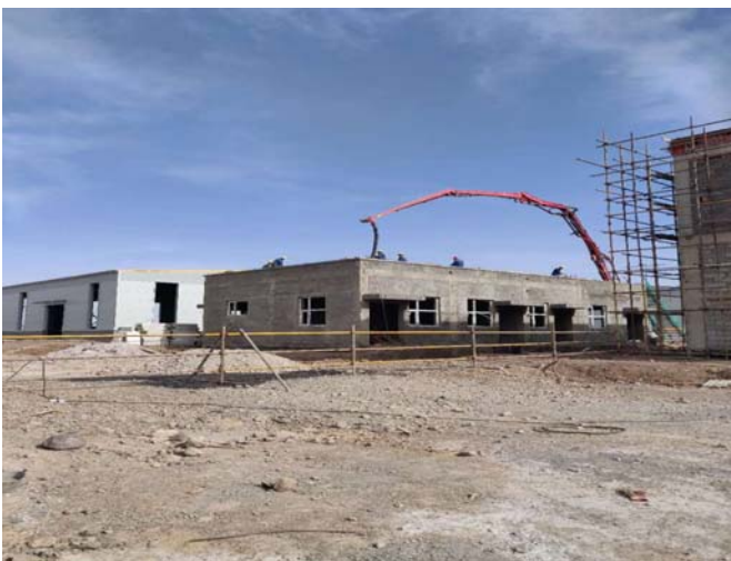
工程建设现状
