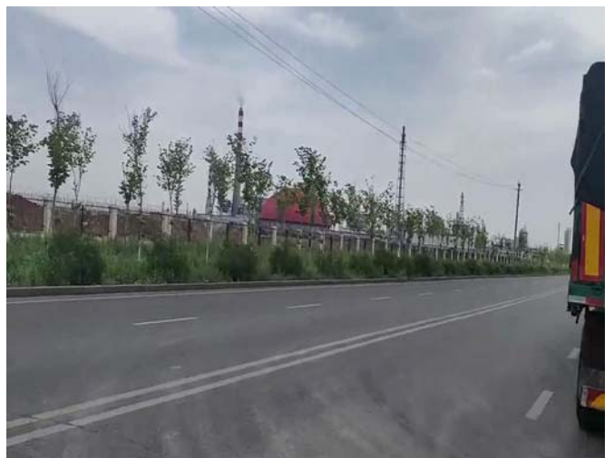
项目区以东道路现状
